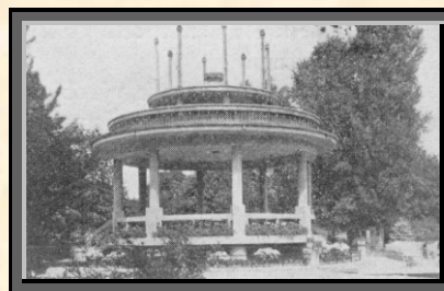
Pavilon v Hranicích
