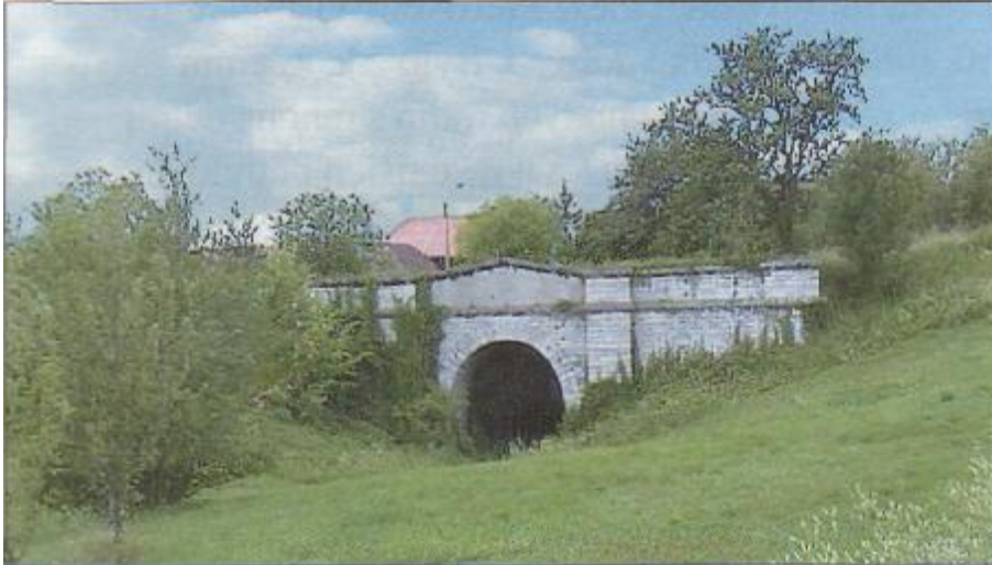
Tunel ve Slavici - portál od Drahotuř. Tunel byl vystaven v letech 1845 -1846 a byl opuštěn 29. května 1895. Je dlouhý 255 m, vysoký 6,75 m a široký 4,8 m. V roce 1992 byl jako technická památka zařazen do seznamu nemovitých, kulturních památek okresu Přerov.
