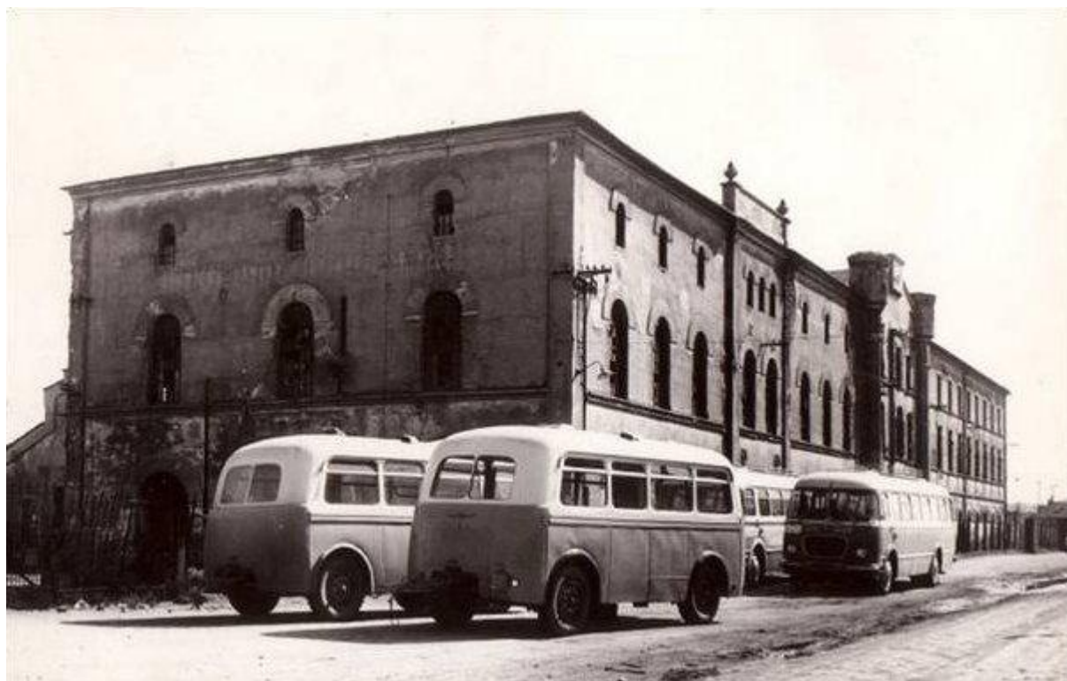
Objekty strojírny Kokora před zbouráním, 1968 (archiv Jiří Rosmus)
