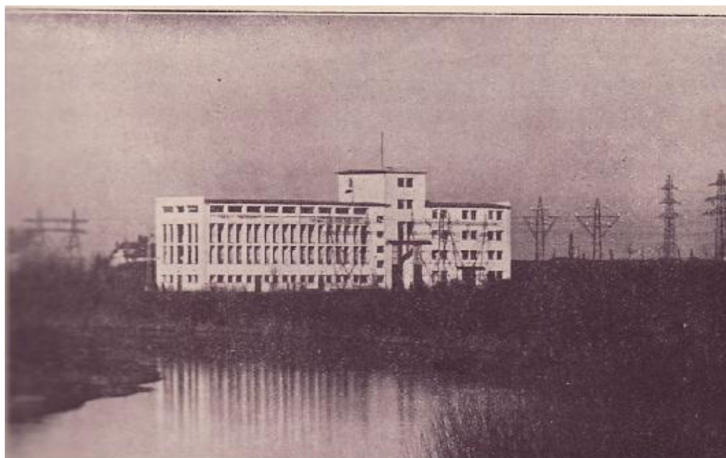
Spínací stanice OSME. V Dluonicích u Přerova 1933
