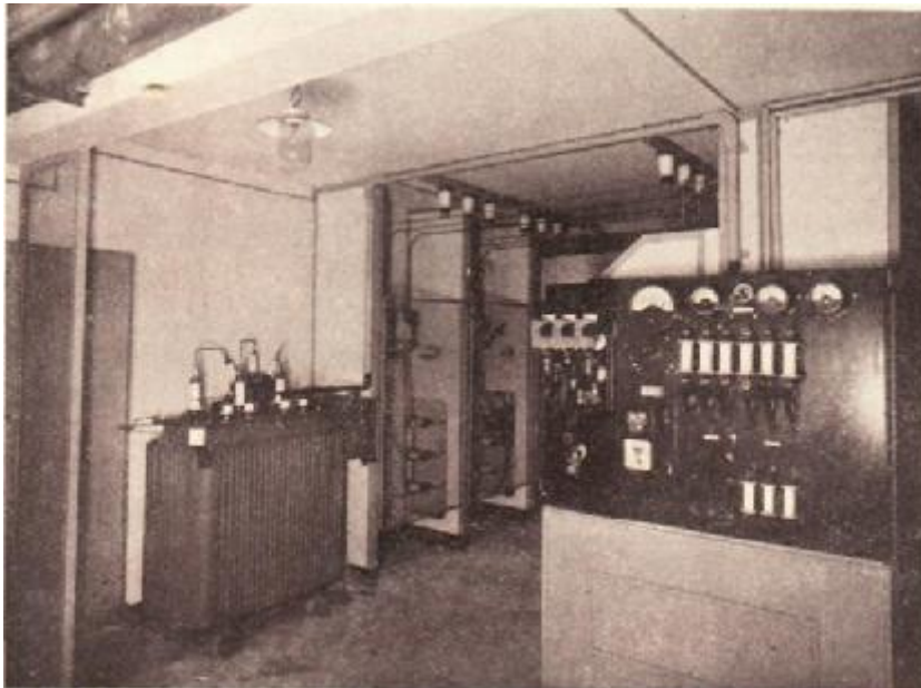
Část transformační a rozvodné stanice 1933
