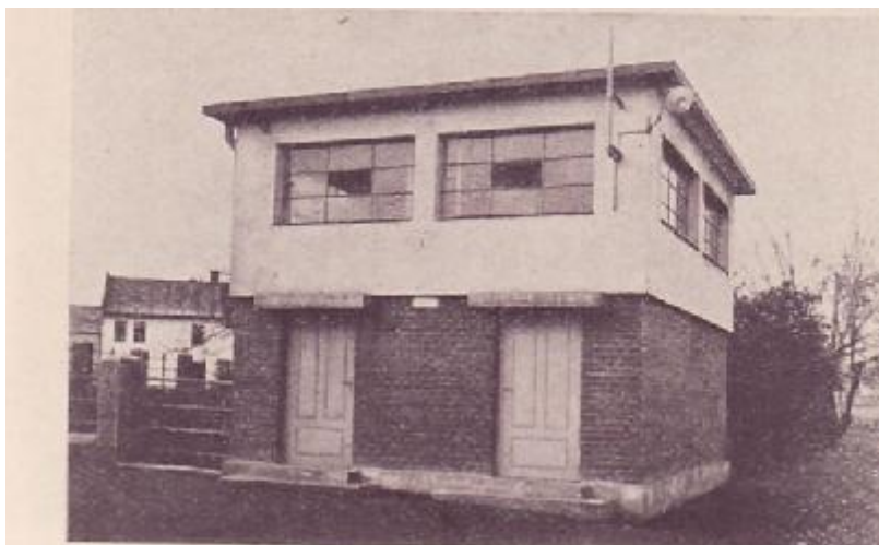
Městské transformační stanice (u Bečvy nám.na Marku )
