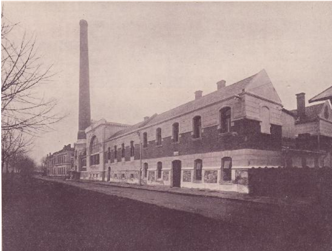
Městská elektrárna Písek
