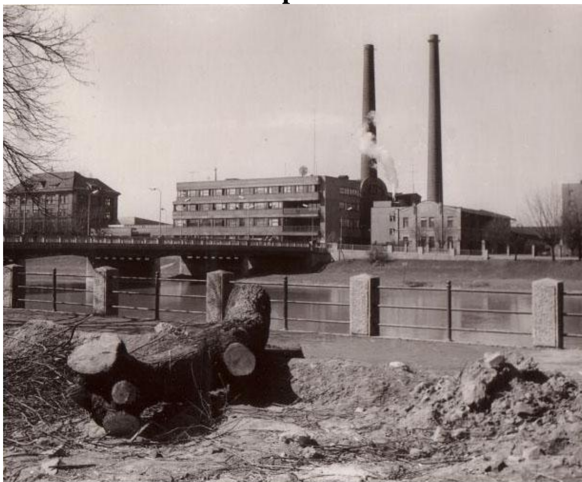
Prerov 50 -tá léta elektrárna
