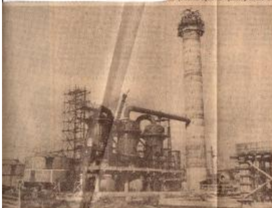
Práce na stavbě chemického kombinátu v Přešově se již začínají realizovat a v jeho průběhu zúčastní se také chemická technika z Polska. Společně s polskými odborníky a pracovníky práce první práce začínají na stavbě výhledu výhledu práce atd.
