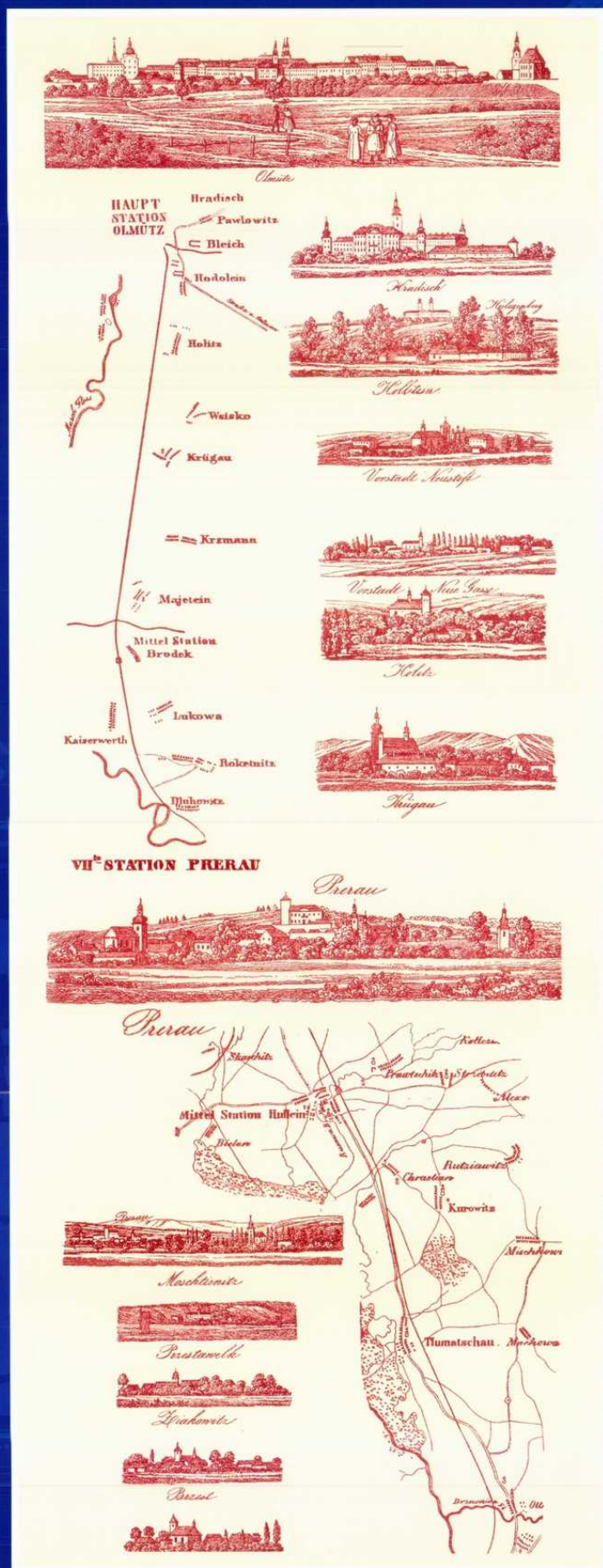
Dobové rytiny představují průběh Severní dráhy císaře Ferdinanda v nově vybudovaném úseku z Uherského Hradiště až do Přerova a Olomouce i s vyobrazením stanic na trati.
