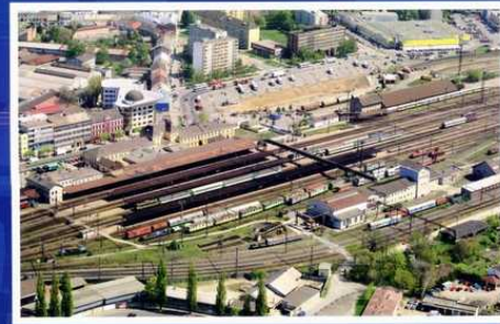
Přerovská železniční stanice v dubnu roku 2009, v horní části snímku jsou vidět první práce na rekonstrukci autobusového nádraží.
