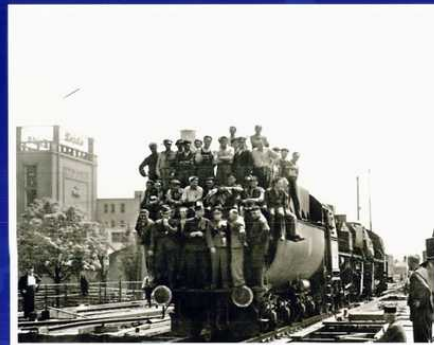
Po provizorní opravě mostu následovaly další práce a již 13. května 1945 byl dán do provozu pro železniční dopravu. Na snímku právě probíhá závěrečná zatěžkávací zkouška.
