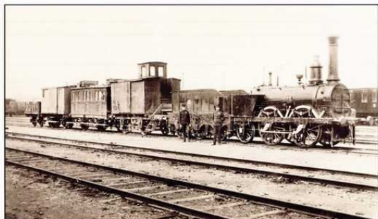
Lokomotiva „AJAX“ v Přerově v letech 1841 až 1842.
