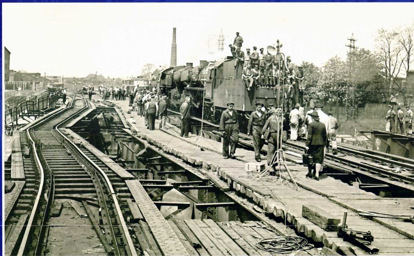
Na zprovoznění mostu pro železniční dopravu se významně podíleli také železničáři z přerovské výtopny a hlavně „traťováci“. Ze snímku jsou patrné škody, které se musely v rychlosti odstranit.
