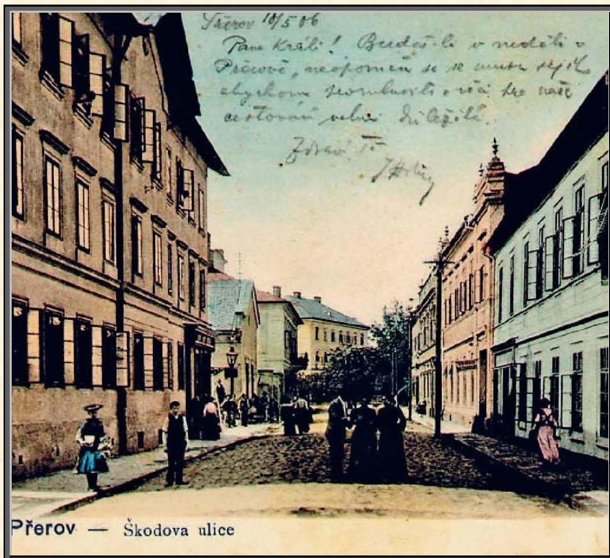
Pohled do Škodovy ulice z Komenského ulice, vpravo Mandlův hostinec, hotel Slavia a hotel Austria (a později Moravia). Vlevo už zbouraný drážní dům z roku 1873
