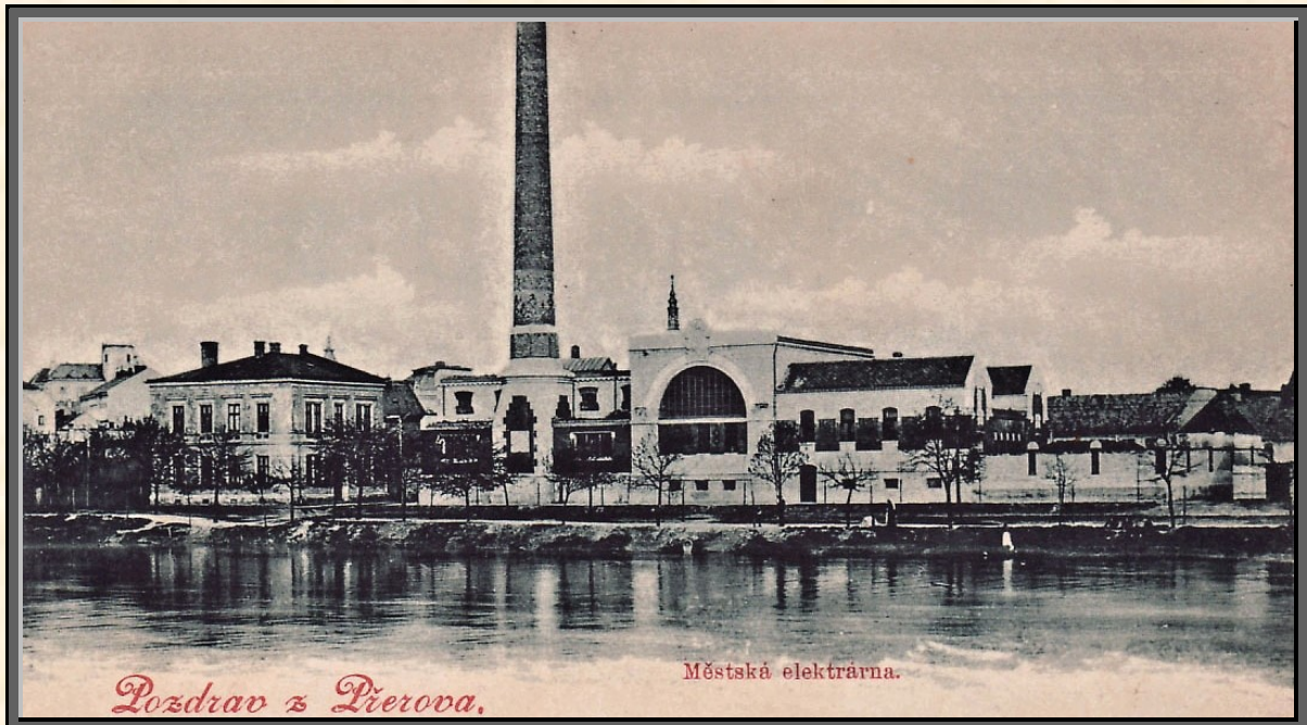
Budova Městské elektrárny na levém břehu řeky Bečvy
