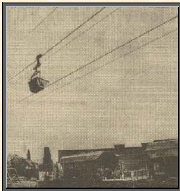
Lanová dráha pro přepravu vápence z Žernové byla vystavěna v roce 1946 a v provozu byla do roku 1975. Na snímku je vozík lanovky při vjezdu do vykládací stanice vápenky
