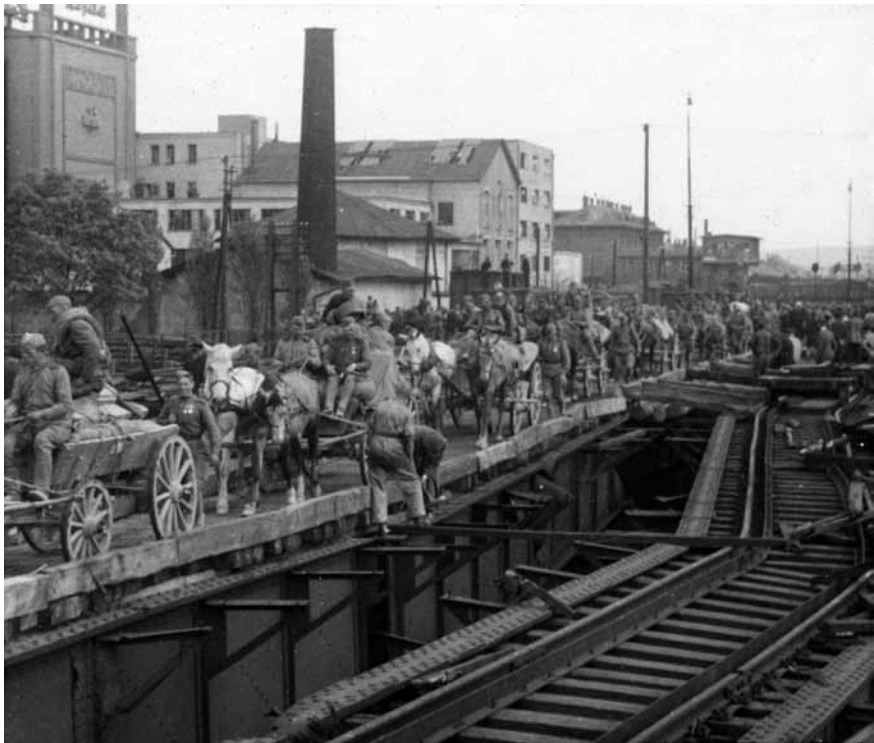
❶ Rudoarmějci přejíždí provizorně opravený železniční most v Přerově, 8. 5. 1945. SOKA Přerov
