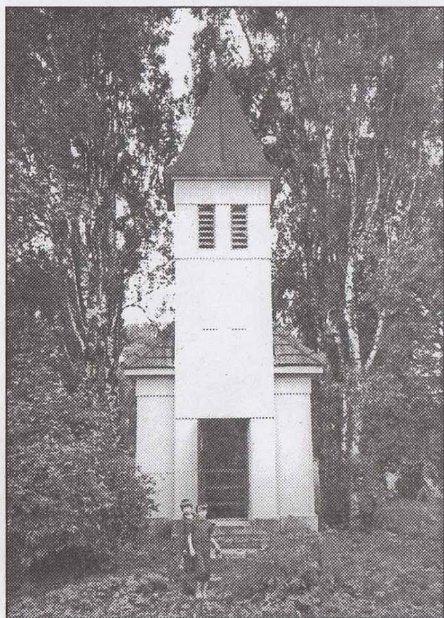
Kaple se zvonící 1985
